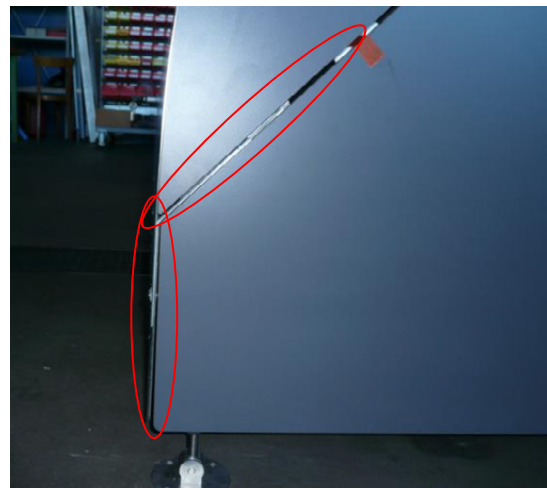
Kontrolle ob Deckel bündig aufliegt
